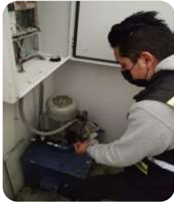
Ilustración 16 Mantenimiento al elevador
