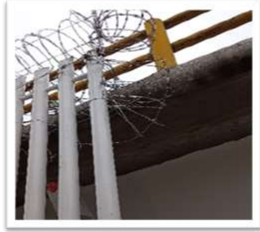
Fotografía 29. Colocación de serpentina en el área perimetral.
